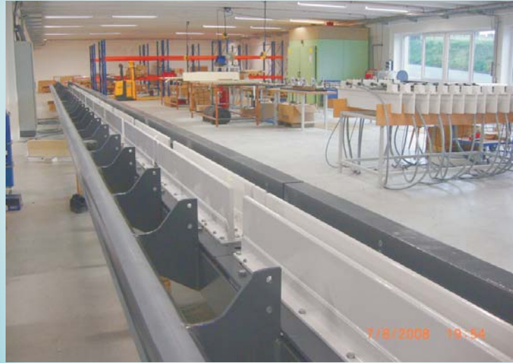
Montage der SLIM Statoren auf die Schiene
